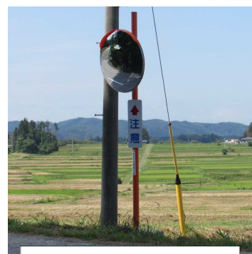
第2区行政区自治会 カーブミラー設置
