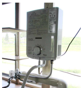
南川目上集会所 ガス給湯器設置
