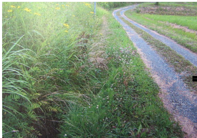
坊ヶ沢線：施工前
