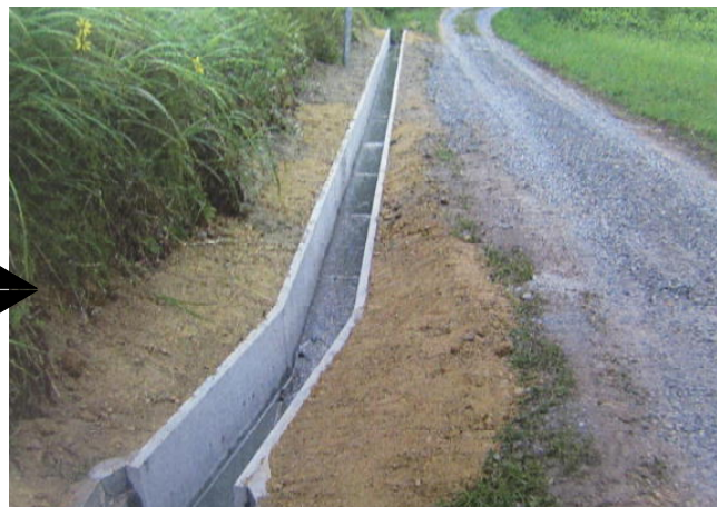
坊ヶ沢線：施工後
